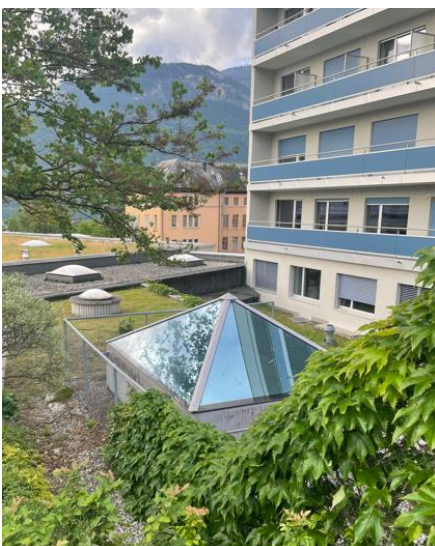
Vue extérieure du dôme permettant un éclairage naturel pour les patients en cours de traitement
